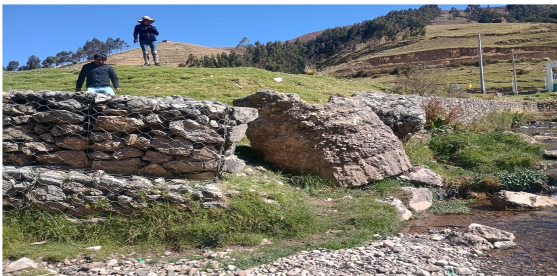
FIGURA N°03: HUNDIMIENTO DEL GAVION EN ESTE TRAMO SE REQUIERE DEL MOVIMIENTO DE MATERIAL CON MAQUINARIA
