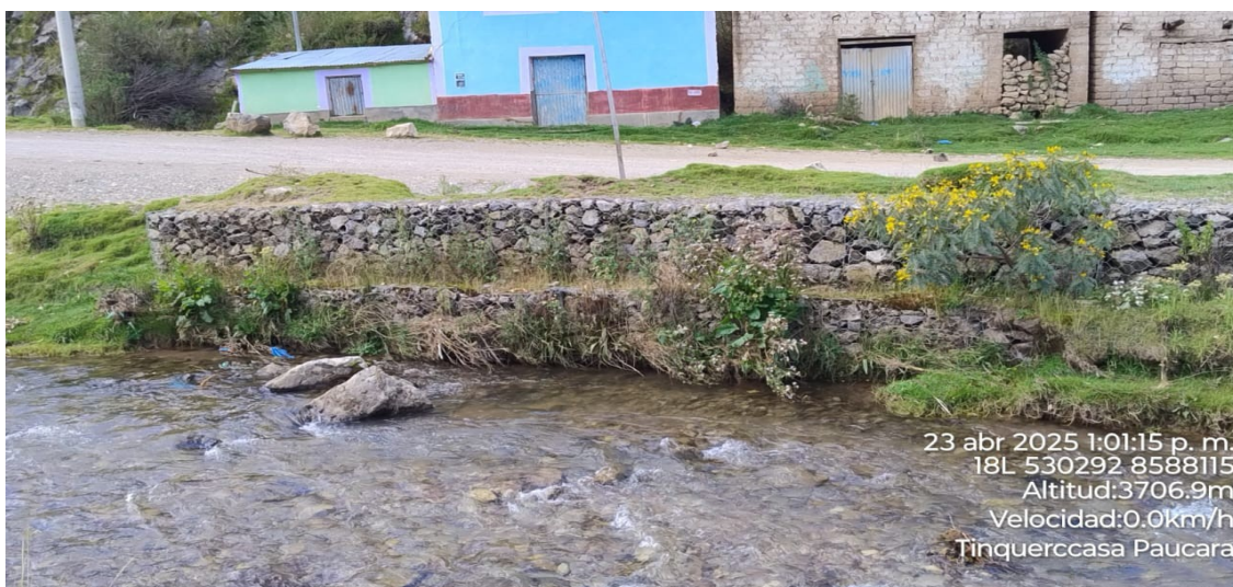
FIGURA N° 02: MURO DE GAVION SIN COLCHON ANTISOCAVANTE, QUE REQUIERE ME MANTENIMIENTO DE CAUCE ASI MISMO CONTRUCCION DE MURO DE GAVIONES
