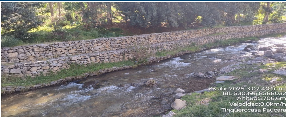
FIGURA N° 01: TRAMO CRÍTICO, MURO DE GAVION SOCAVADO, SE REQUIERE DEL MATENIMIENTO DEL CAUCE DEL RIO TINQUER (RIO TINQUERCASA)
